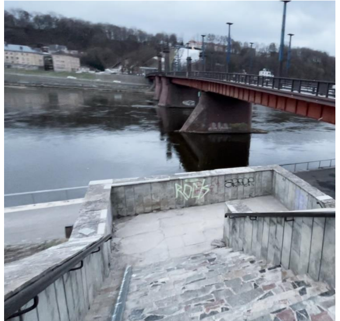
9. Nuo Karaliaus Mindaugo pr. laiptai link pėsčiųjų tunelio žiūrint Pietų kryptimi link krantinės. Laiptai iš granito dangos. Atraminių sienelių apdailos pažeistos, ištrupėjusios, atraminės sienutės sienos su įtrūkimais ir kitais pažeidimais. Neužtikrinimas žmonių su negalia tinkamas nusileidimas iki požeminės perėjos. Neužtikrinamas tinkamas apšvietimas saugiam patekimui į požeminę pėsčiųjų perėją.
