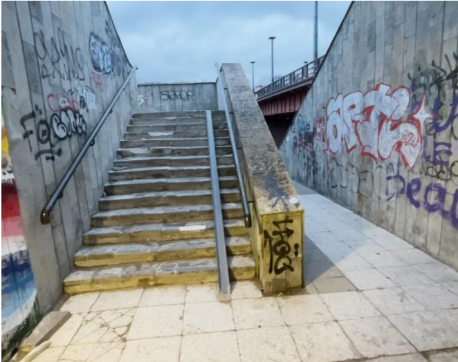
5. Laiptai iš požeminio tunelio link krantinės žiūrint Pietų kryptimi. Neužtikrinimas žmonių su negalia tinkamas nusileidimas iki požeminės perėjos. Esami laiptai iš betono dangos su įtrūkimais ir kitais pažeidimais. Neužtikrinamas tinkamas apšvietimas saugiam patekimui į požeminę pėsčiųjų perėją.
